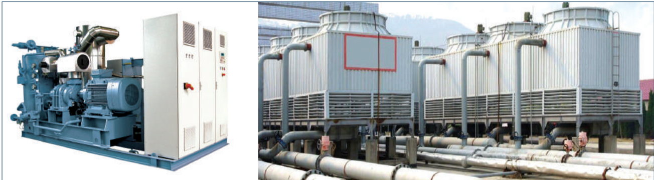
Նկար 40. Ջրով հովացվող չիլերի օրինակ (ծախից) և Նույն համակարգի հովացնող աշտարակը (աջից):
