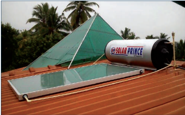
Նկար 46. Արևային ջրատաքացման սովորական համակարգ՝ բաղկացած կուտակիչից և տաք ջրի գլանաձև բաքից:
